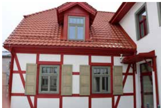
Ēka Cēsu ielā 7, Limbažos drīz uzņems iemītniekus. Foto: Sabiedrisko attiecību speciāliste Beāte Kožina
