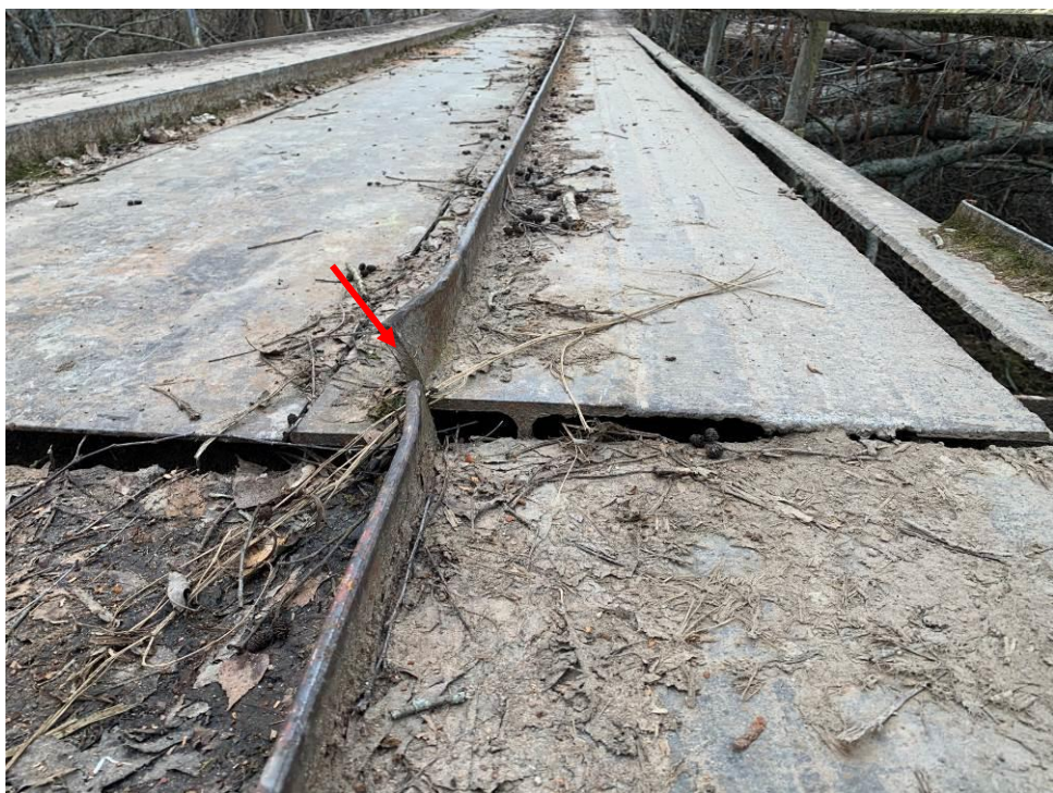
4.att. Bīstami leņķdzelžu stūri. Skats virs upes balsta Nr.3.
