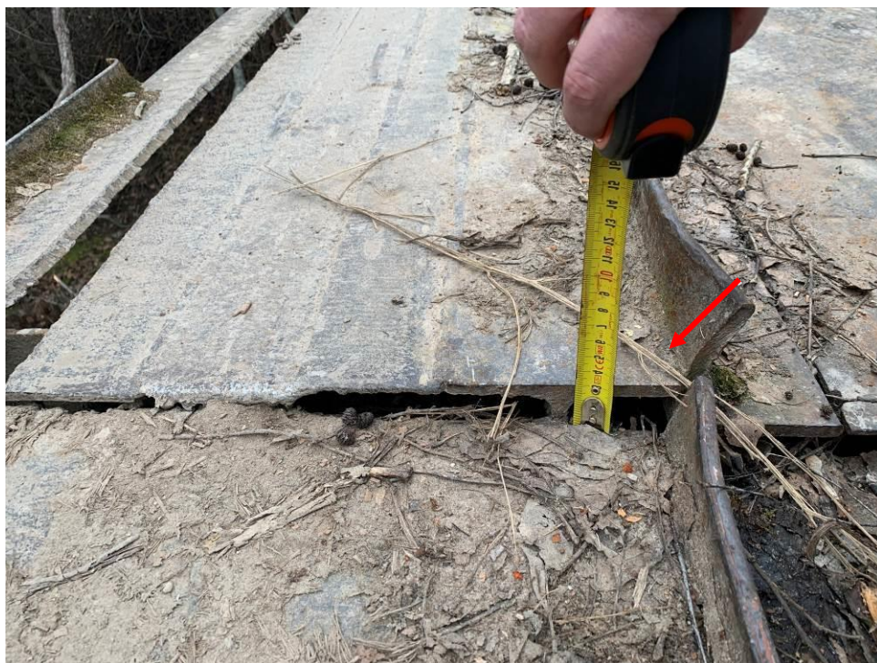
5.att. Virs balstiem tērauda klājs nobīdījies un veido sliksni. Skats virs upes balsta Nr.3.
