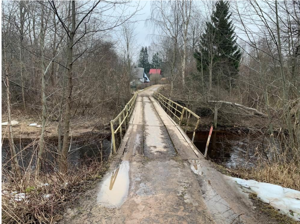
1.att. Tilta brauktuve. Skats Ziedu ielas puses.
