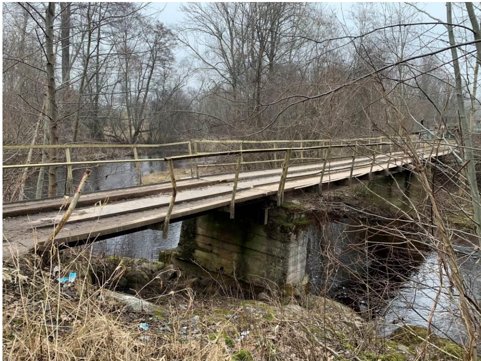
2.att. Tilta sānskats Skats no lejteces puses.
