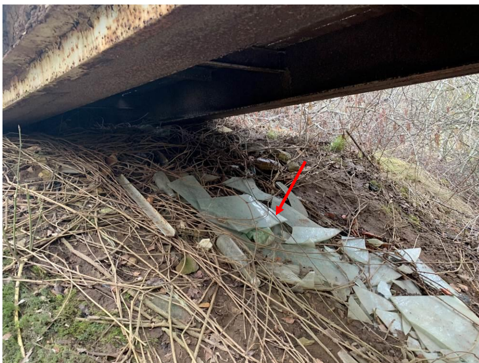
26.att. Sanesumi, siju konstrukcija saskaras ar grunti. Skats uz krasta balsta Nr.4.
