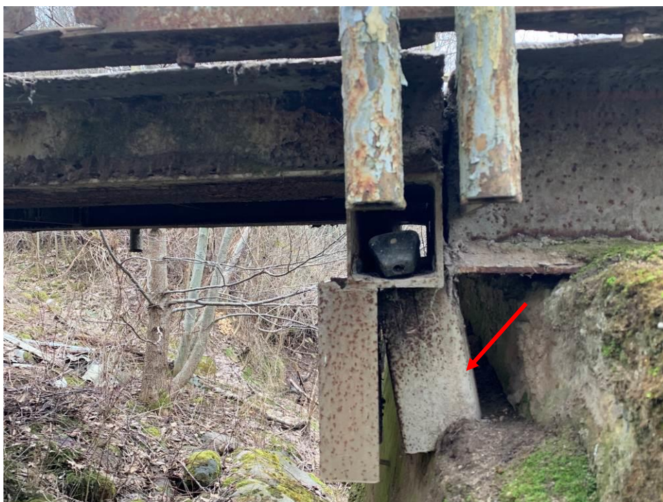
14.att. Bīstami balstīts 1.laidums. Skats uz virs upes balsta Nr.2 lejteces pusē.
