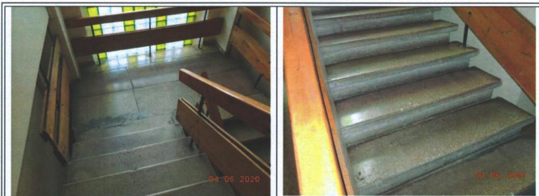
Attēls 4.10.3: Vairākas kāpnes ir bojātas
