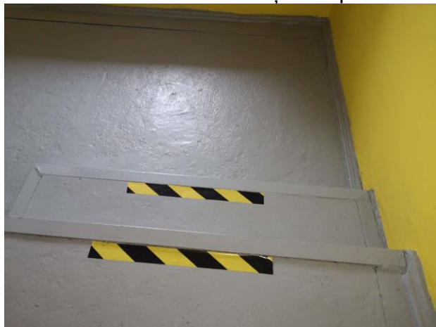
Foto 4.12.5 krāsota betona virsma
