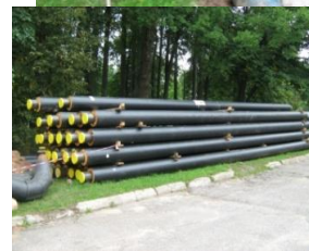
2.4 att. Siltumtīklu rekonstrukcija Limbažos 2011.gada vasarā
