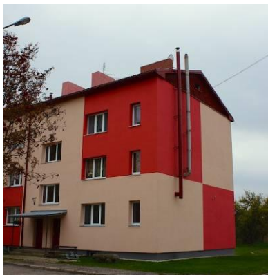
1.16a.att. Individuālas apkures sistēmas daudzdzīvokļu ēkā Ozolainē
