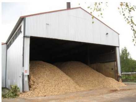
1.7a.att. Šķeldas uzglabāšanas noliktava
