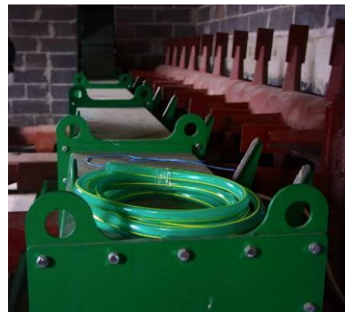
1.12b.att. Koksnes šķeldas padeves sistēma Umurgas katlu mājā
